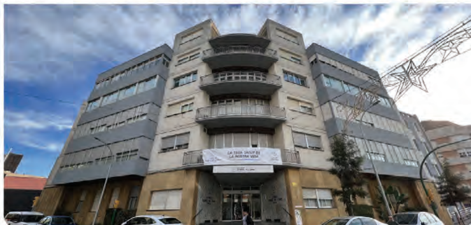
A l'Hospital Santa Creu hi treballen més de 500 professionals, mentre que la Clínica Terres de l'Ebre la fan possible un total de 250 treballadors i treballadores.
